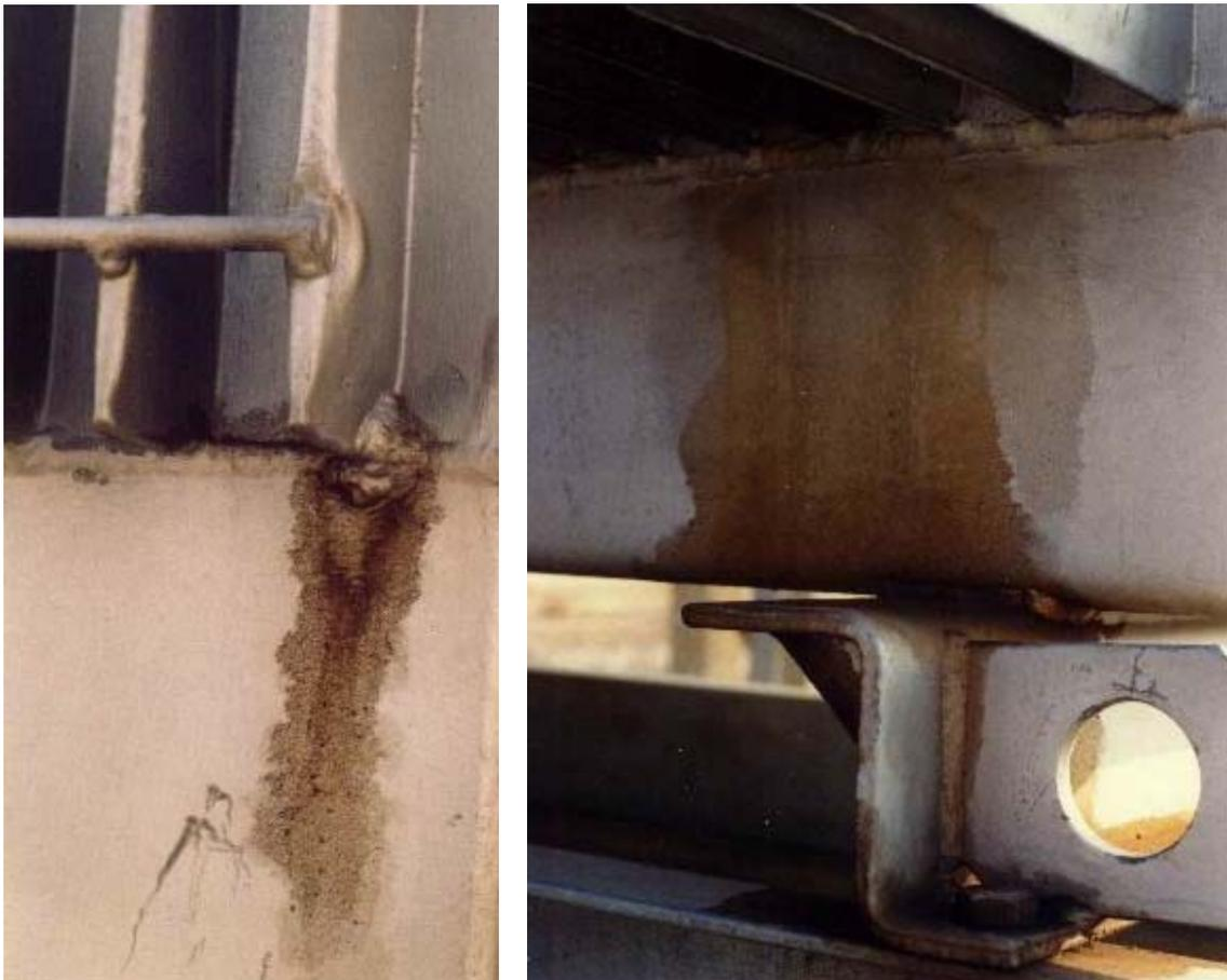
Abdichtung von Ölleckagen an Großtransformatoren mit MM-metall oL-StahlKeramik, Härter rot und Härter gelb.
